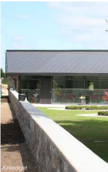
Kirkediget videreføres i bygningens gavl
